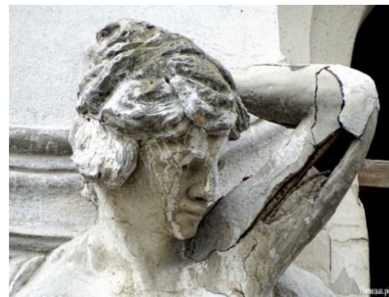
Разрушение скульптуры под действием кислотных дождей
